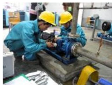
设备现场维修
